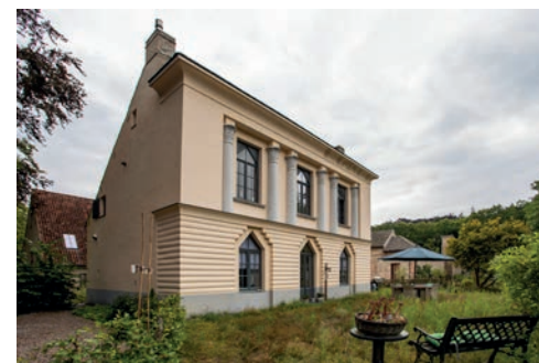
5 | Brugge: restauratie Kasteelhoeve Forreist, © Kris Vandevorst
