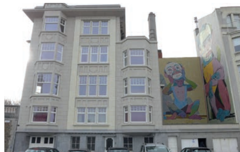
16 | Oostende: gevelrestauratie Appartement Compas, © Pieter Boons
