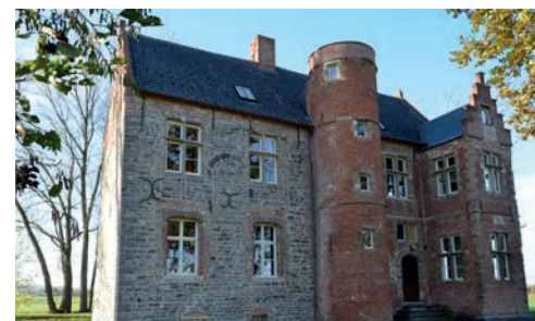
11 | Kluisbergen: restauratie Kasteel ter Donckt, © Luc Vandewynckel
