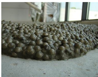
Figuur 75: Isolerende uitvullingslaag met EPS korrels
