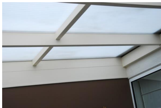
Figuur 100: Veranda met polycarbonaatplaten
