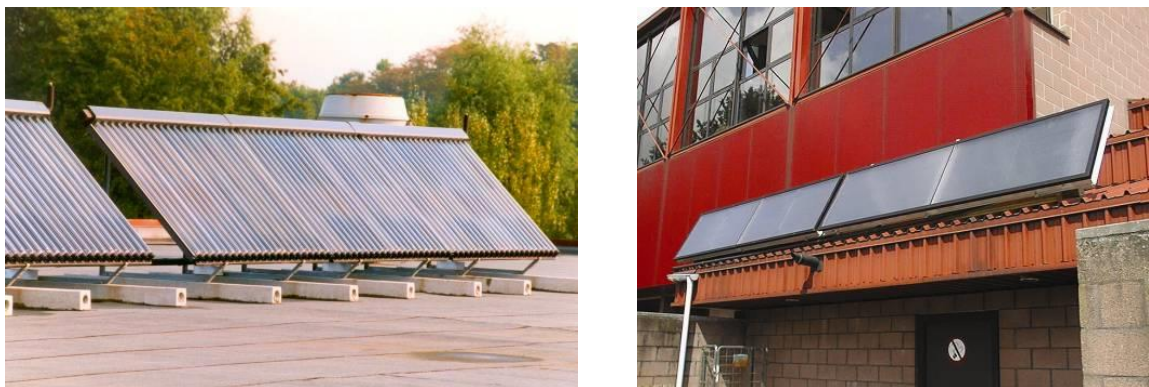
Figuur 238: Buiscollectoren (links) en vlakke plaatcollectoren (rechts)
