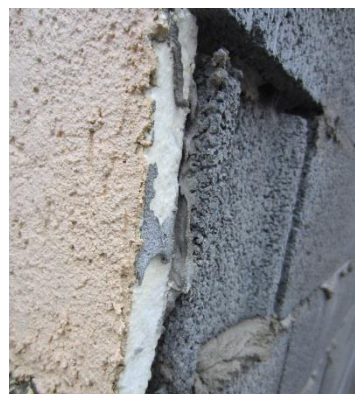
Figuur 63: Pleisterlaag (roze) op EPS (wit)
