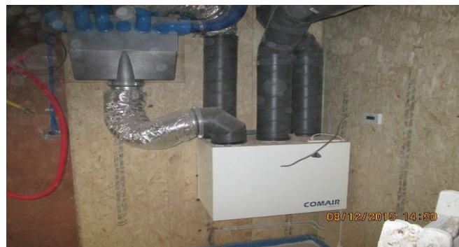
Figuur 228: Ventilatieunit voor mechanische toe-en afvoer met warmterecuperatie
