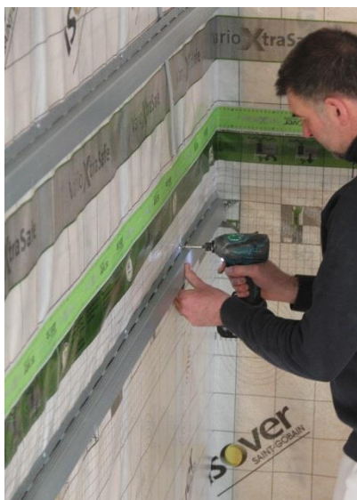
Figuur 58: Bevestiging van (metalen) lattenstructuur
