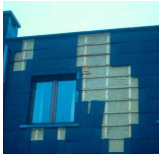
Figuur 65: Luchtlaag achter beplating
