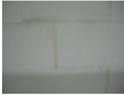
Figuur 71: Cellenbetonblokken van na de jaren '80
