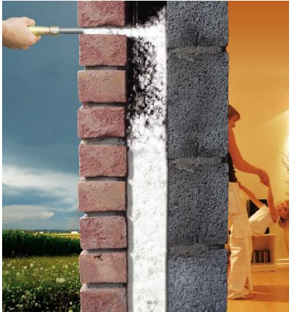
Figuur 68: Na-isoleren van traditionele spouw
