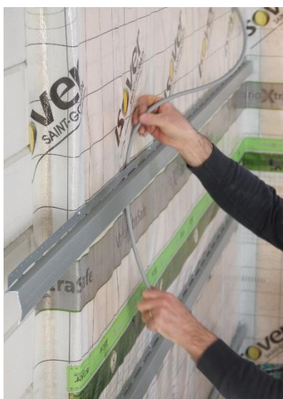
Figuur 59: Doorvoeren van leidingen door leidingenspouw
