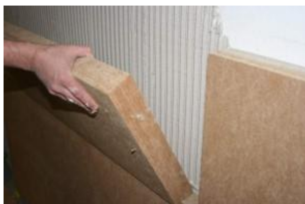
Figuur 56: Lijmen van binnenisolatie
