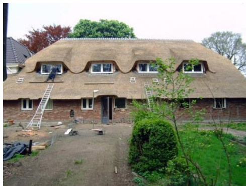
Figuur 84: Hellend dak in riet
