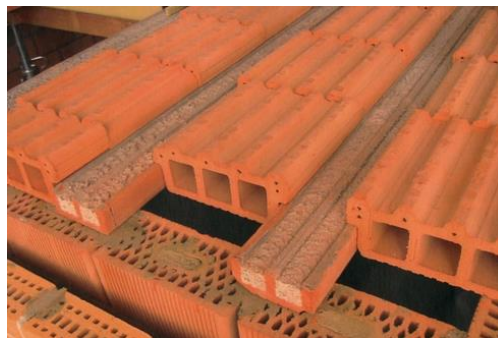
Figuur 78: Potten en balken
