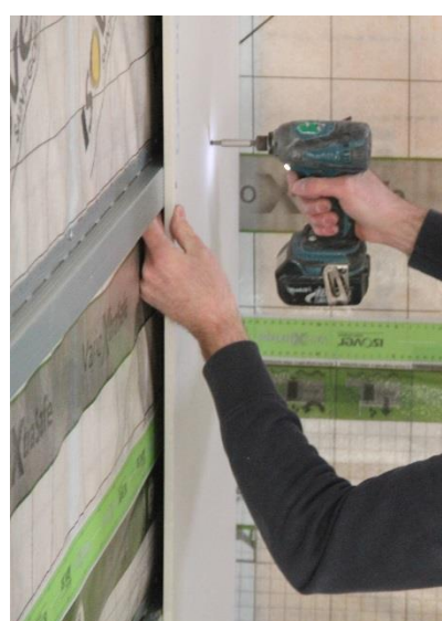
Figuur 60: Afwerkingsplaten op leidingenspouw
