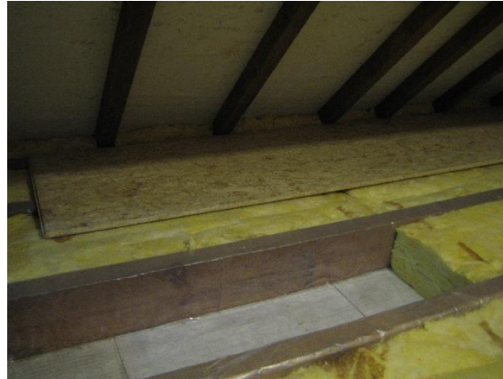
Figuur 88: Zichtbaar gelaten plafondisolatie in houten roostering
