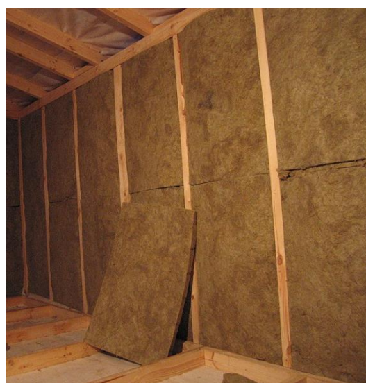
Figuur 55: Stijl- en regelwerk bij binnenisolatie: houten structuur
