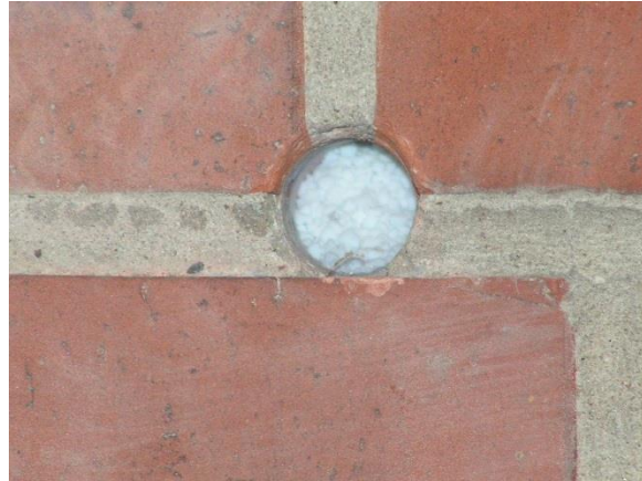
Figuur 67: Inblaasopening bij na-isolatie
