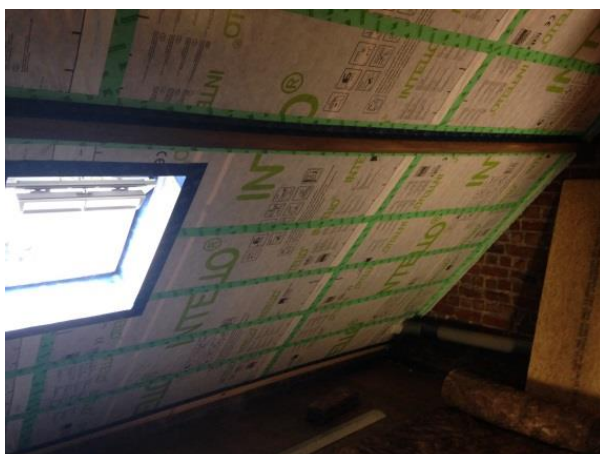
Figuur 74: Dampscherm bij een hellend dak
