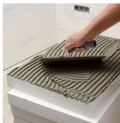
Figuur 57: Lijm op binnenisolatie
