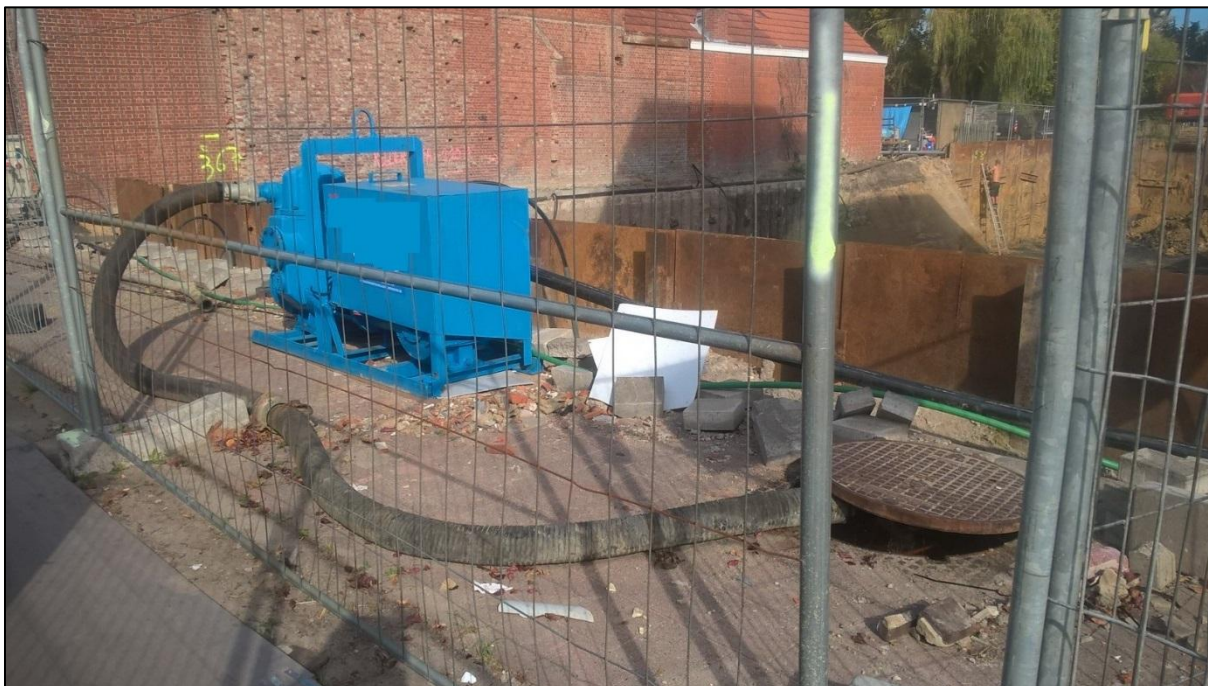
Figuur 3: Bemaling met lozing van het bemalingswater, echter zonder de wettelijk vereiste debietmeter.
