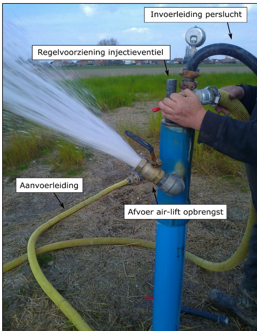
Figuur 28: Illustratie van een putkop van een retourbron, met aanduiding van enkele essentiële elementen.
