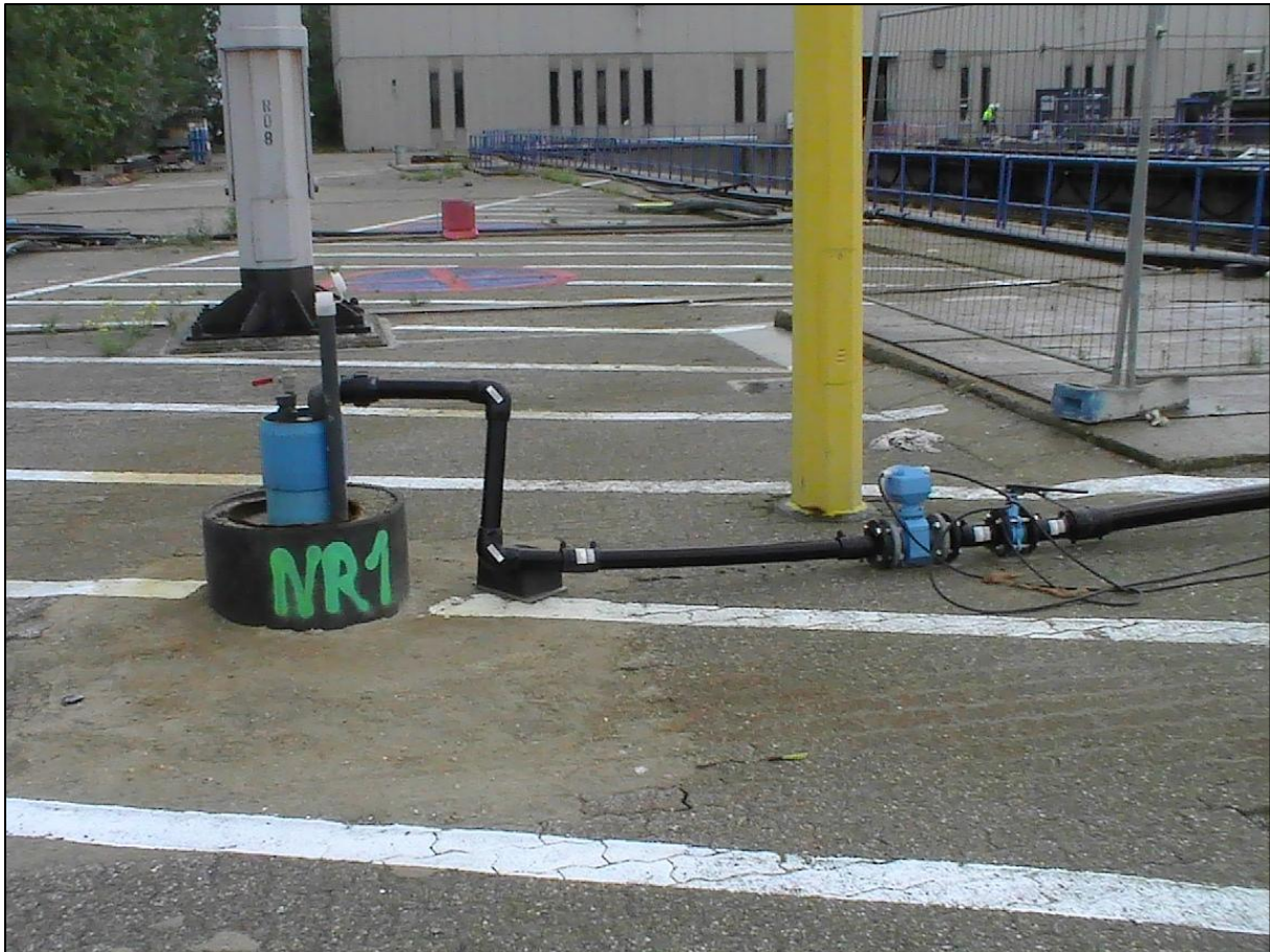
Figuur 24: Uitvoering van een retourbemaling door middel van een retourbron.
