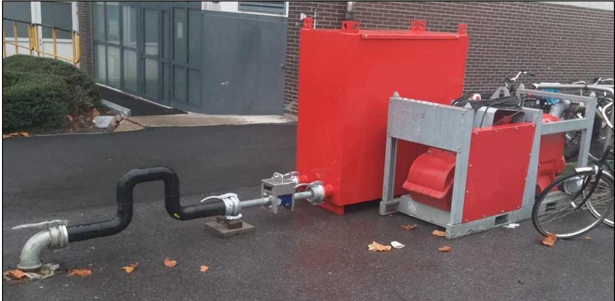
Figuur 1: Correct opgestelde elektromagnetische debietmeter bij een bemaling door middel van een zuigerpomp. Let op de ontluuchtingsbak en het leidingwerk voor en voorbij de debietmeter en de verhoogde afvoer voorbij de debietmeter.
