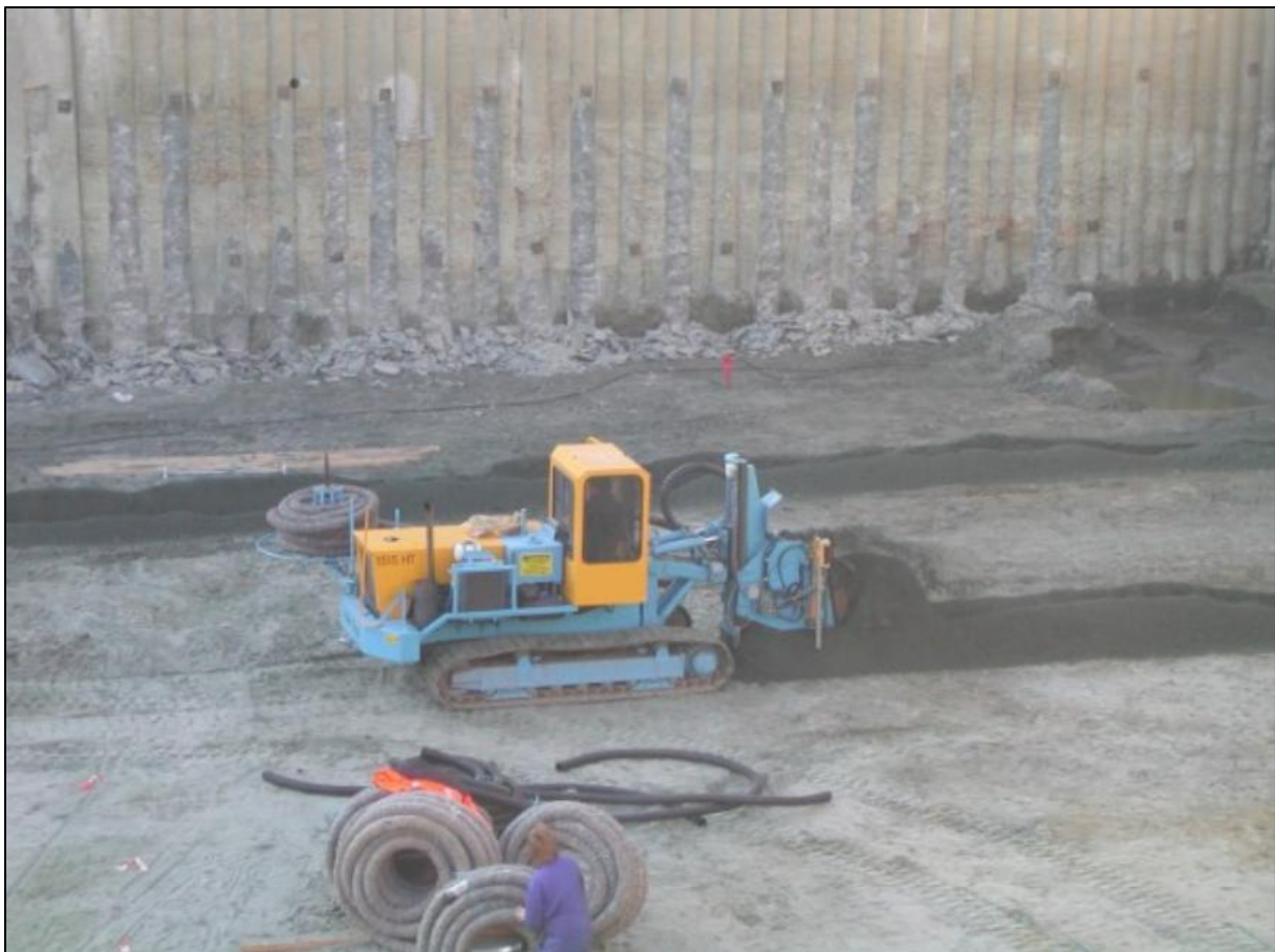
Figuur 6: Trekken van een horizontale drain in een reeds gedeeltelijk uitgegraven bouwput.
