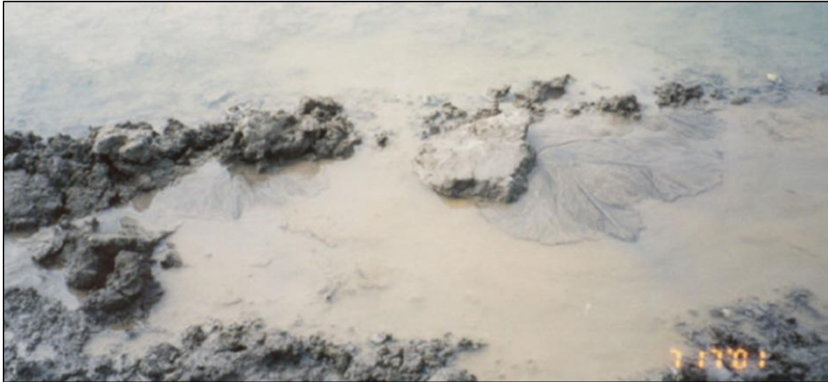
Figuur 20: Opbarsten van de bouwputbodem, met het ontstaan van 'bronnen' en zandtransport.
