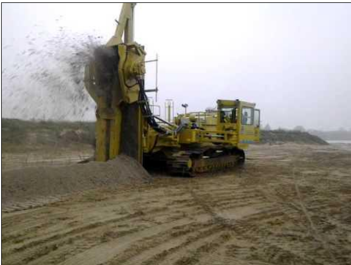
Figuur 5: Kettinggraafmachine aan het werk.
