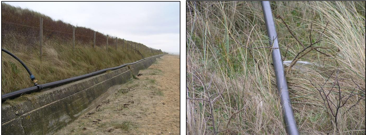
Figuur 30: Uitvoering van een oppervlakkige infiltratie in de duinen door middel van leidingen waar gaten zijn in aangebracht.
