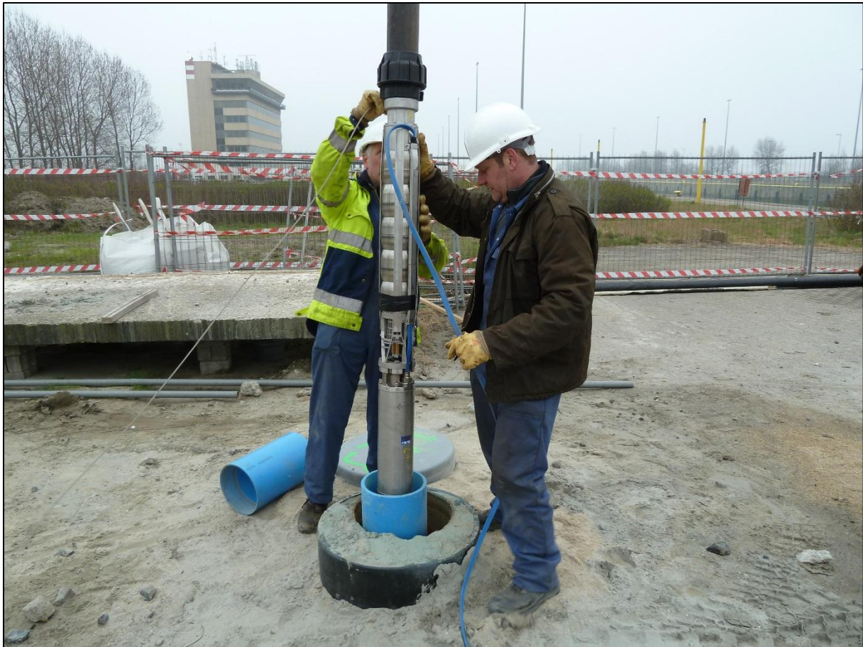
Figuur 17: Plaatsing van een onderwaterpomp in een dieptebron met behulp van een kraan.
