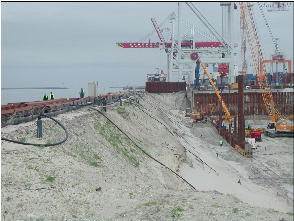
Figuur 18: Uitvoering van een bemaling met dieptebronnen.
