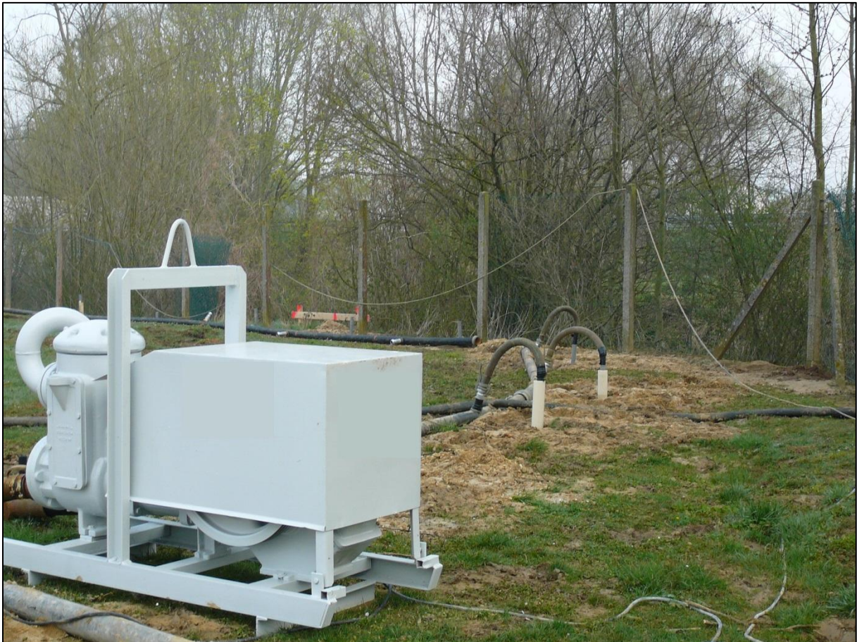
Figuur 9: Uitvoering van een filterbemaling met zuigerpompen.
