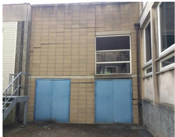
Figuur 1: Differentiële zettingen ten gevolge van een verschil in grondwaterverlaging over de lengte van een gebouw (links) en ten gevolge van heterogene funderingen (rechts). Bron: Jan Maertens.
