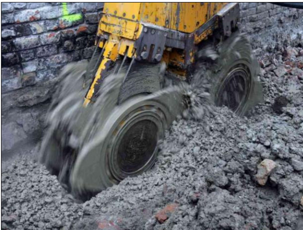
Figuur 3: Frezen van een soilmixwand type 2 (bron: Lameire).
