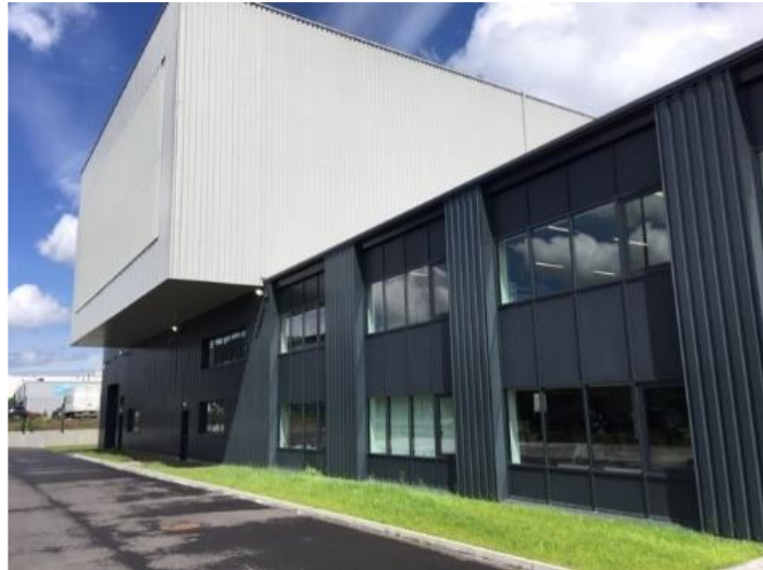
Figuur 1-1: Het Depot in Vilvoorde met onderaan uiterst links in beeld de garage, centraal de kantoorruimtes en bovenaan de raadpleegruimte.
