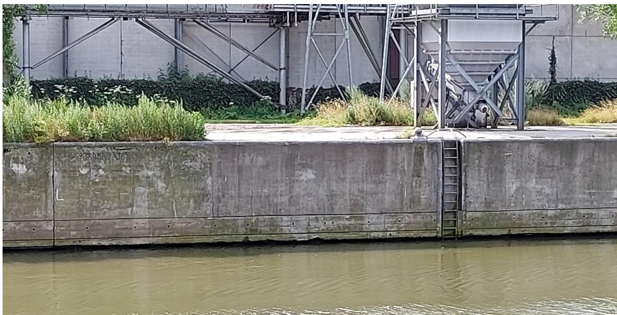
Foto 3. Betonnen oever op traject R2.
