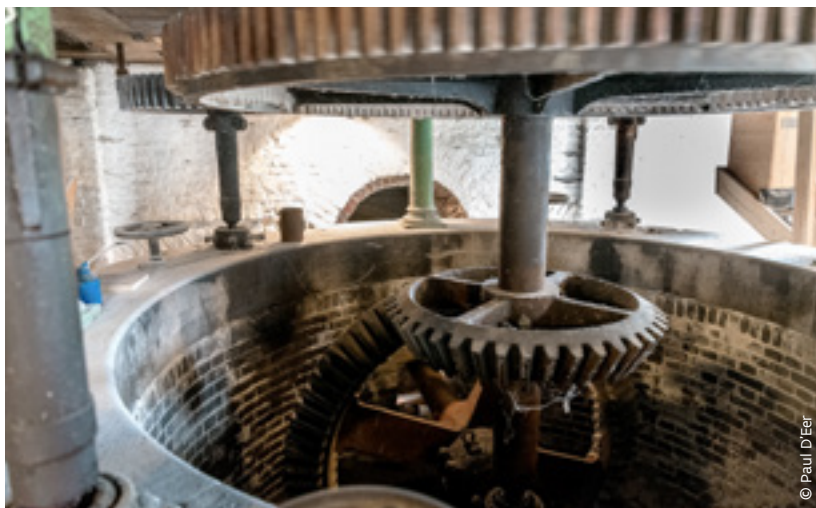
Zicht op de asput op de maalvloer, met – in de asput – de kamwieloverbrenging van de water- op de maalas en daarboven het grote spoorwiel waarop vier sterrenwielen kunnen ingeschakeld worden.
