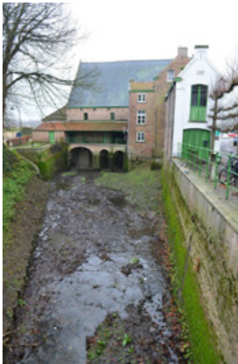
Het molengebouw met onderaan de drie sluisopeningen: links de vloedsluis naar de spaarkom, rechts daarvan de dubbele ingang van de maalsluis.
