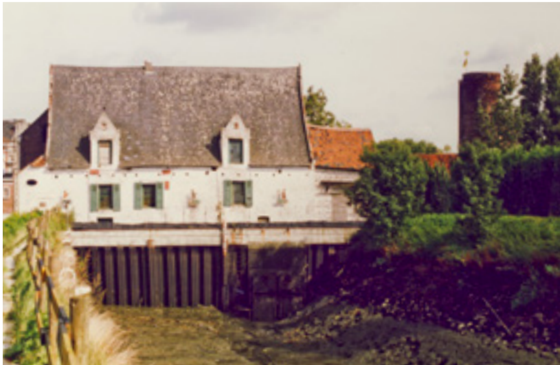
Voor de restauratie zat het volledig wit gekaleide gebouw half verscholen achter een metershoge stalen kofferdam met sluis. Links was voor de ingang van de molen een portiek aangebouwd, rechts zijn nog de pannendaken van de oude stallen zichtbaar met daarachter de Graventoren
