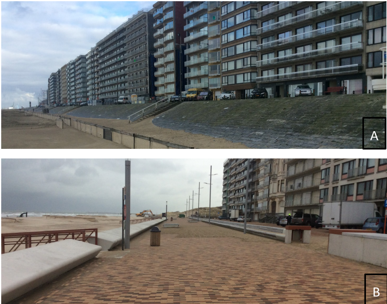
Figuur 2 – Voorbeeld Toetsspoor dijk: A. hard zeewerend talud te Blankenberge – B. golfdempende uitbouw te Wenduine (foto's W+B – Toetsing kustveiligheid 2015)
