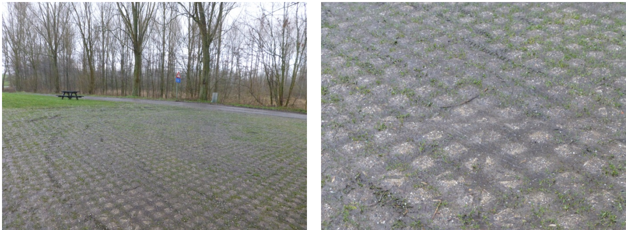
Figuur 13 – Doorgroeitegels ter plaatse van verkeerswisselaar
