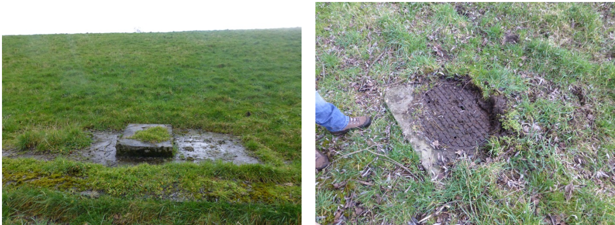
Figuur 14 – Betonnen mangaten nabij de teen van de dijk en mangaten van de riolering.
