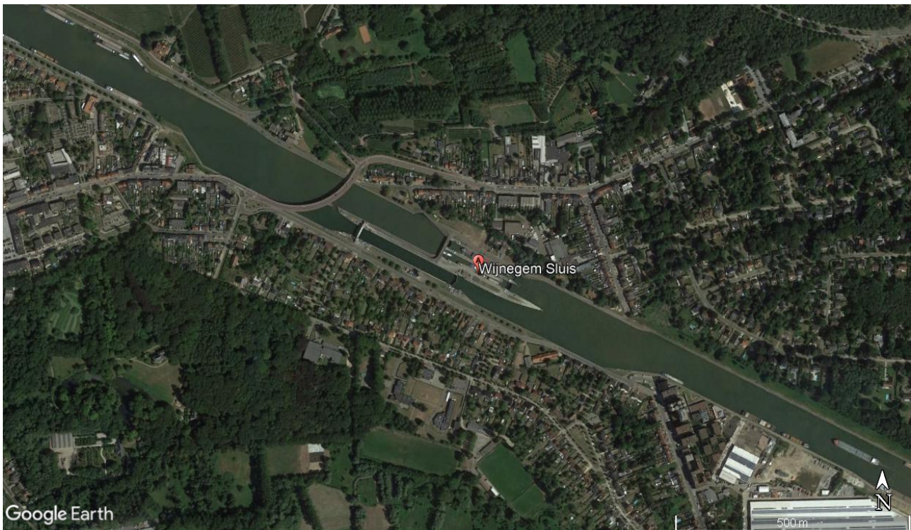
Figuur 7 – Sluizencomplex te Wijnegem als voorbeeld van sluisomgeving met lokale vaarasverschuiving
