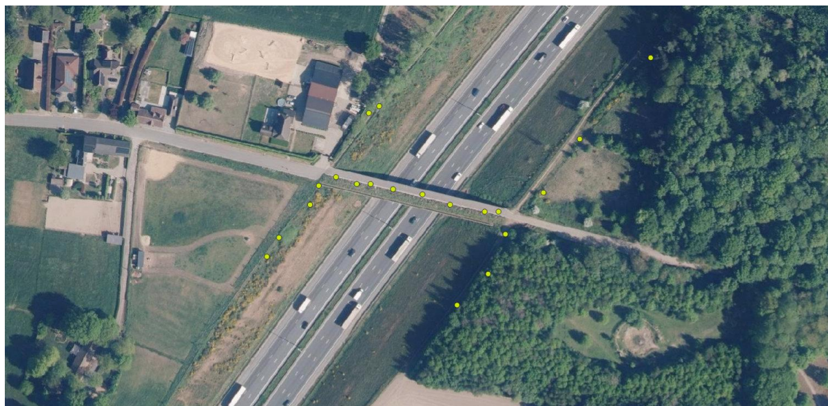
Figuur 30: Locaties van de reptielenmatten op en nabij de bermbrug van Waasmunster.
