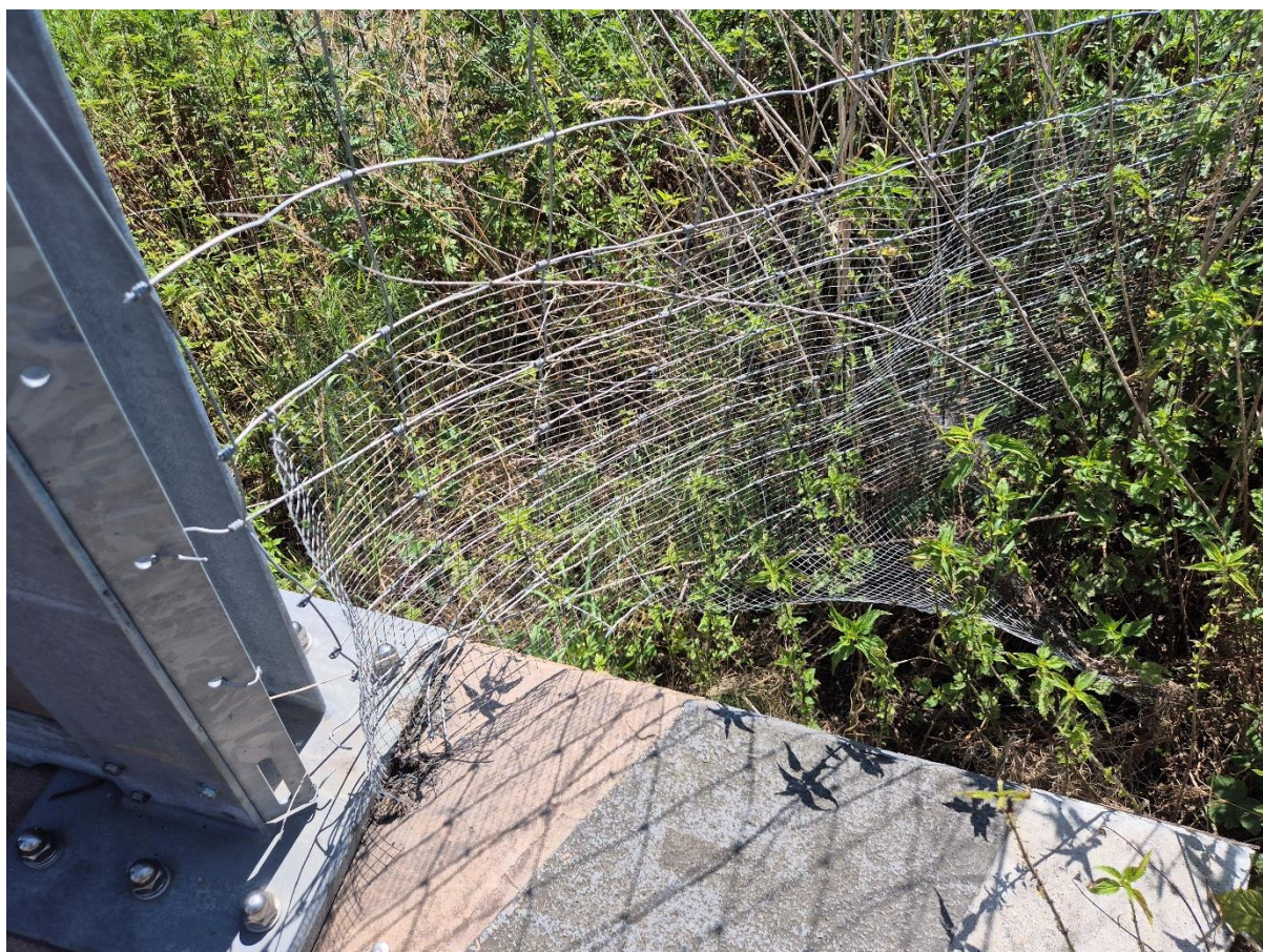
Figuur 32: Waar het raster aansluit op de brug, bevindt zich momenteel een opening waar ook grotere zoogdieren doorheen kunnen (foto: Joris Everaert).
