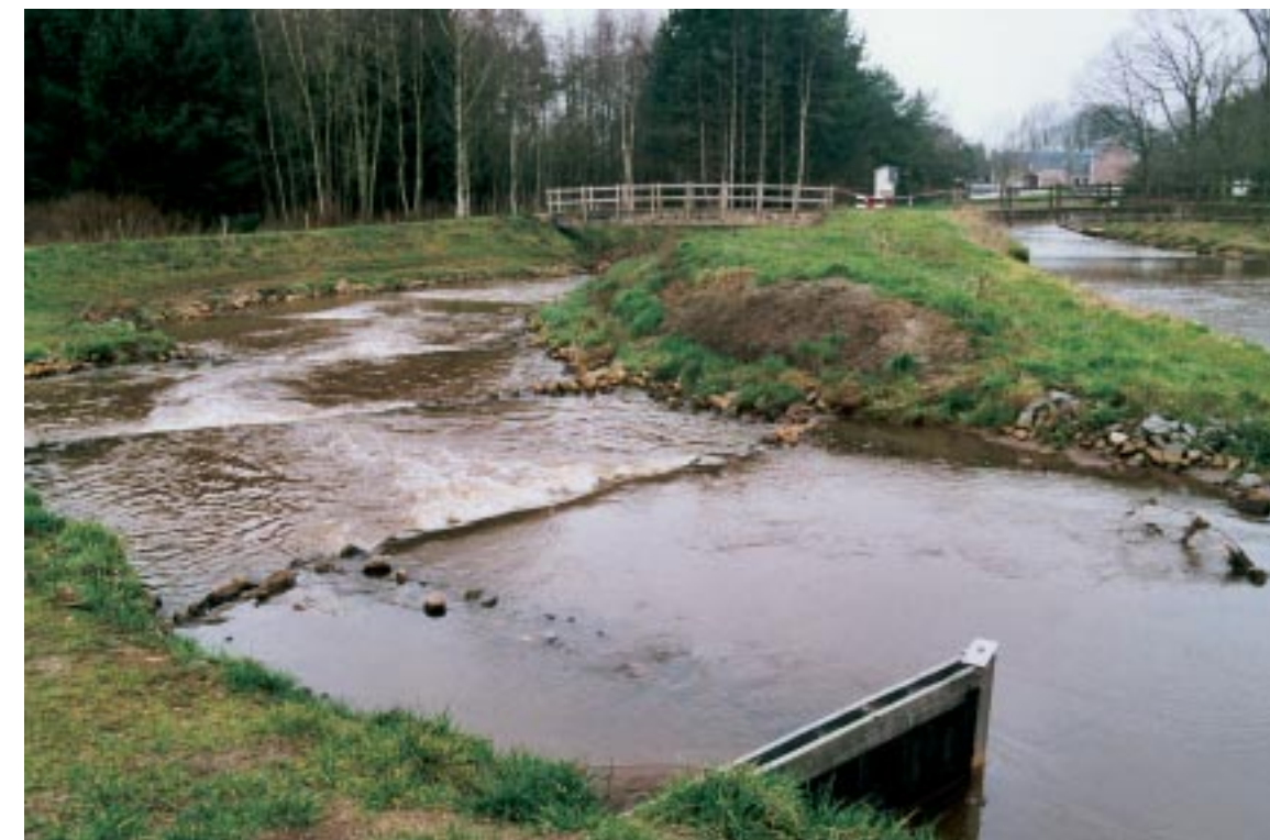
Vistrap op de Kleine Nete te Herentals. Ook voor de andere vismigrieknelpunten op de Kleine Nete is de aanleg van nevengeulen en/of bekken-trappen voorzien.
