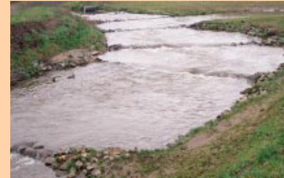
Dankzij de vistrap kunnen vissen terug de stuw te Herentals passeren en bovenstroomse zones opzoeken.
