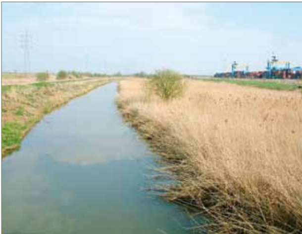
figuur 43: De half toe geslibde en van riet voorziene Hoofdgracht ter hoogte van de Main-Hub
