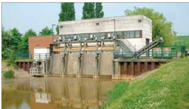
figuur 109: Pompemaal Vlaemschen Dijck en pompkamer
