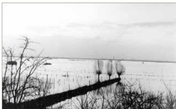
figuur 7: 1 februari 1953 Berendrechtpolder en bres bij fort Berendrecht: foto's Berendrecht online
