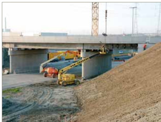
figuur 73: Bouw zwevende rotonde boven de R2 tbv Deurganckdok
