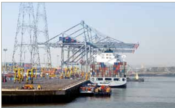
figuur 115: Deurganckdok Terminal AGT
