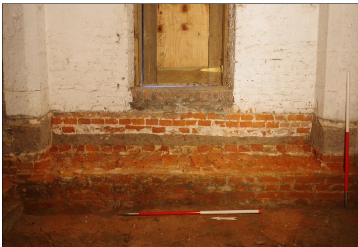
Figuur 1-19. Gebouw II, zuidelijke ruimte, overzichtsfoto van de oostmuur met twee natuurstenen sokkels op een bakstenen funderingsbasis.
