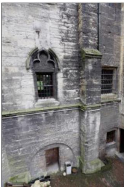
Figuur 1-17. Overzichtsfoto van de oostmuur van Gebouw II (exterieur) (met dank aan Bressers Architecten bv).
