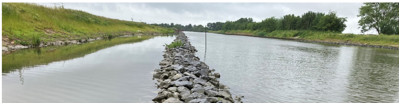
Figuur 1 – Vooroever met een breuksteenberm Leie ter hoogte van de meetsectie
