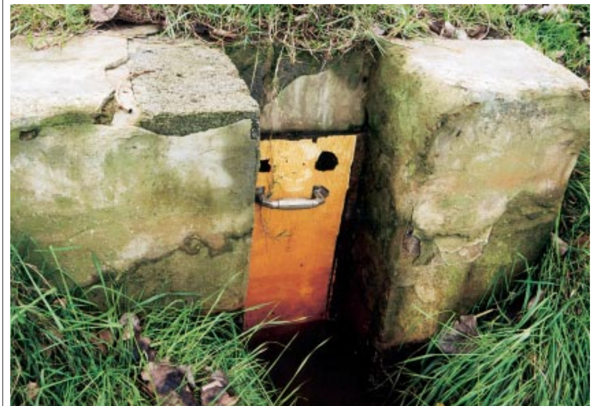
Terugslagkleppen moeten verhinderen dat zout en zoet water met elkaar in contact komen.
