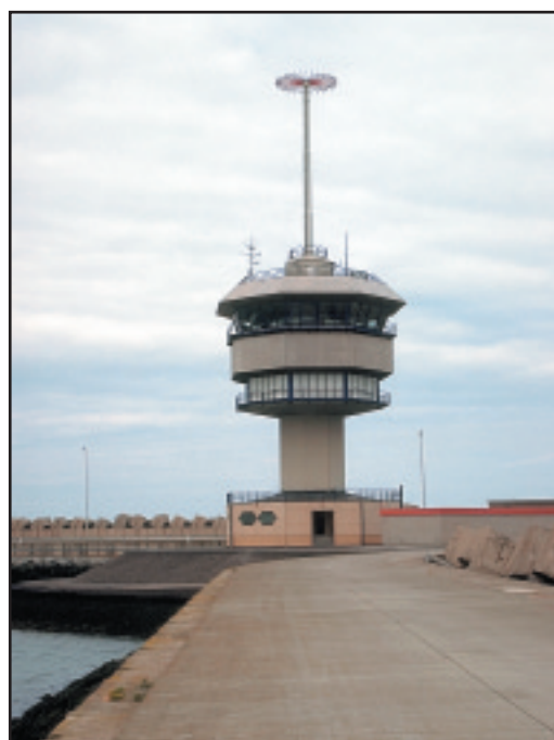
Radarcentrale Westelijke Havendam Zeebrugge
