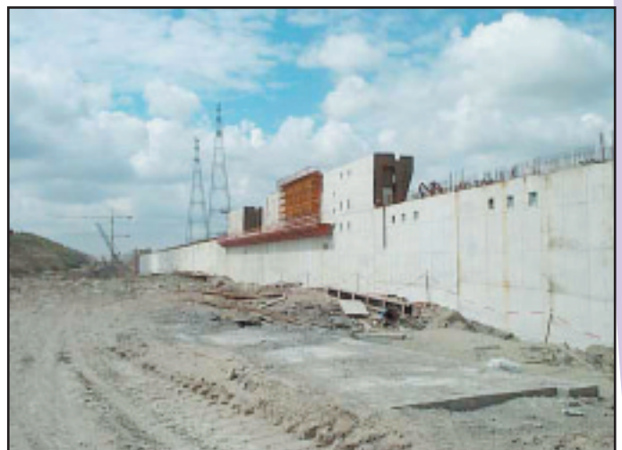
De bouw van de kaaimuur (Deel I) van het Deurganckdok
