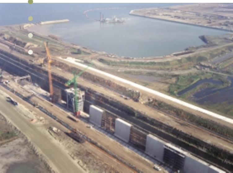
graafwerken bij het Verrebroekdok
