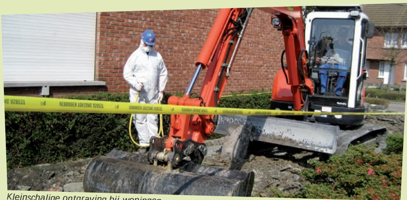
Kleinschalige ontgraving bij woningen
