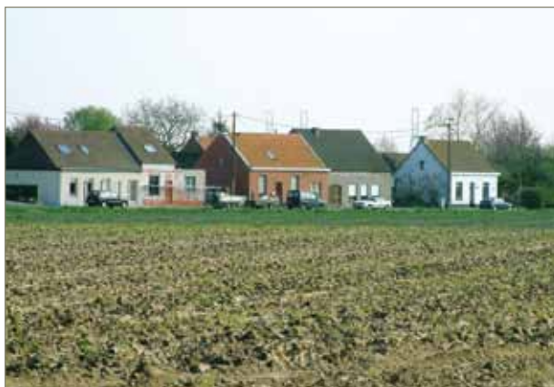
figuur 54: Zandvliet Zoutedijk
