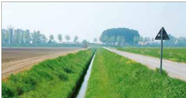
figuur 30: Afvoer van de Zoetwaterkreek in de Oud Arenbergpolder
