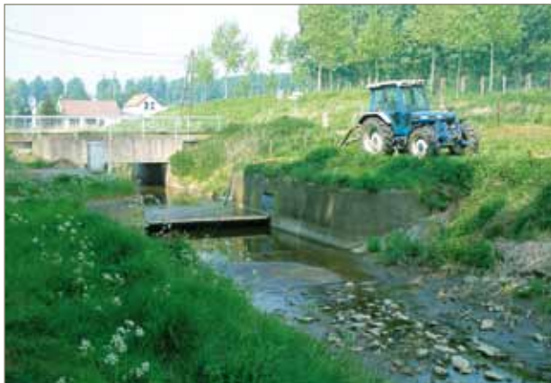
figuur 23: Stuw op de Noord-zuidverbinding, waar net de stuw de landbouwers bij droogte oppervlaktewater afpompen
