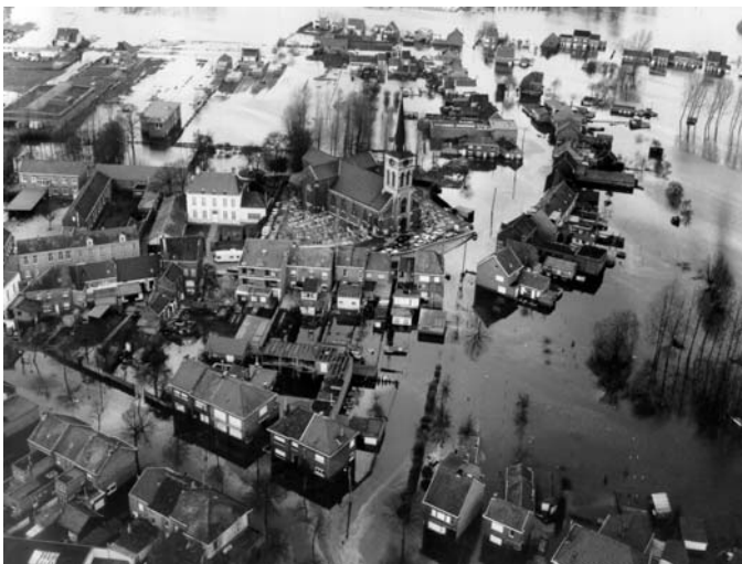
Figuur 5: Ruisbroek staat blank na de overstroming van 1976
