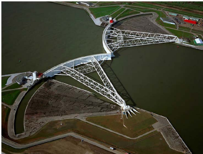
Figuur 10: Stormvloedkering van het type "nieuwe waterweg"
