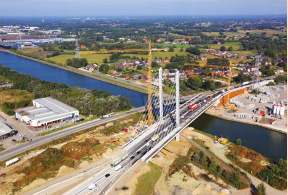
De nieuwe brug over het Albertkanaal in de Kempen.
