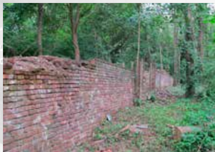
Voor de restauratie.
