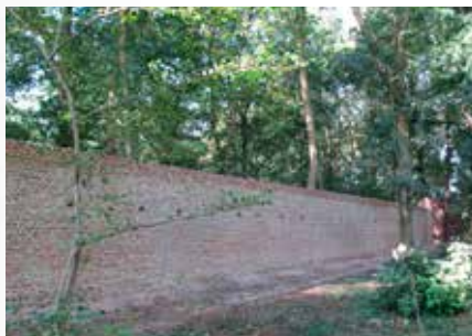
Na de restauratie.
