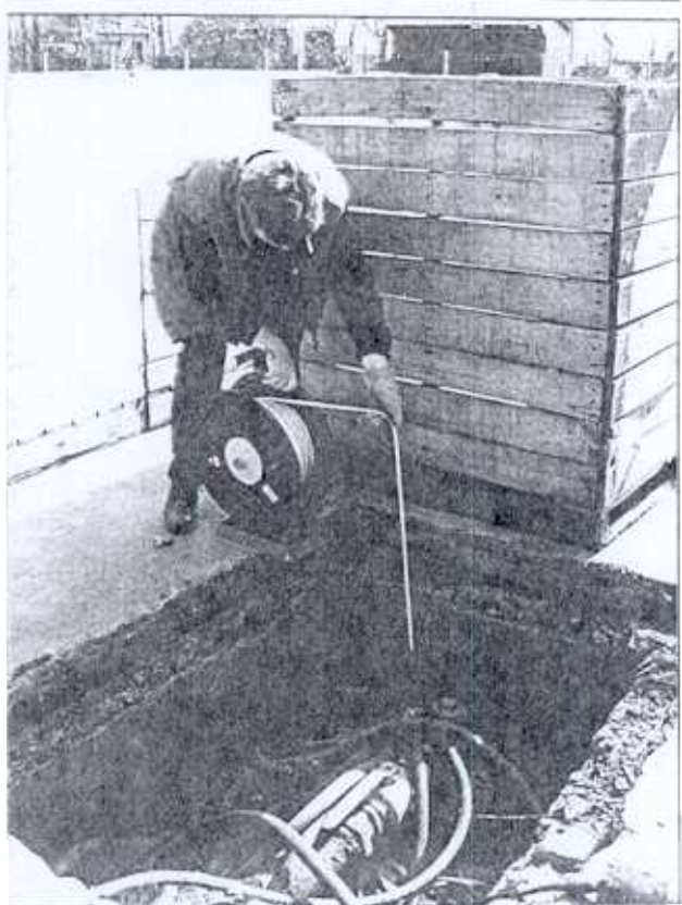
uitvoeren peilmetingen in een boorput
