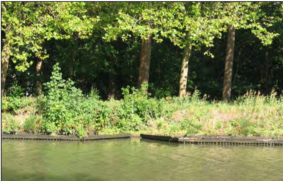
Foto 5: Vooroever langs het kanaal Bochelt-Herentals (oost) – vooroeverinsprong aan plasberm (Grontmij-Econnection)
